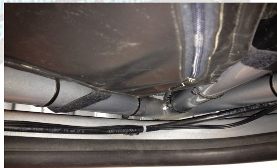
Εικόνα 30: Πέρασμα σωληνώσεων μεταξύ κλωβού και αμαξώματος
