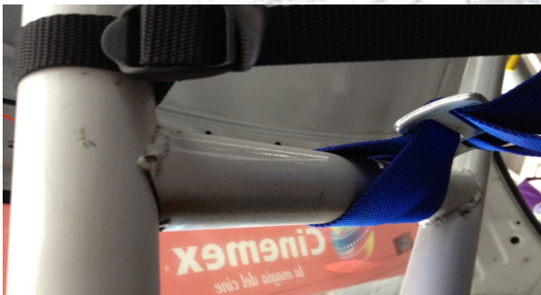
Εικόνα 29: Λανθασμένη κόλληση σωλήνας στήριξης ζωνών ασφαλείας
